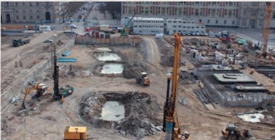
Abb. 1: Die Baustelle des Humboldt-Forums im April 2013
